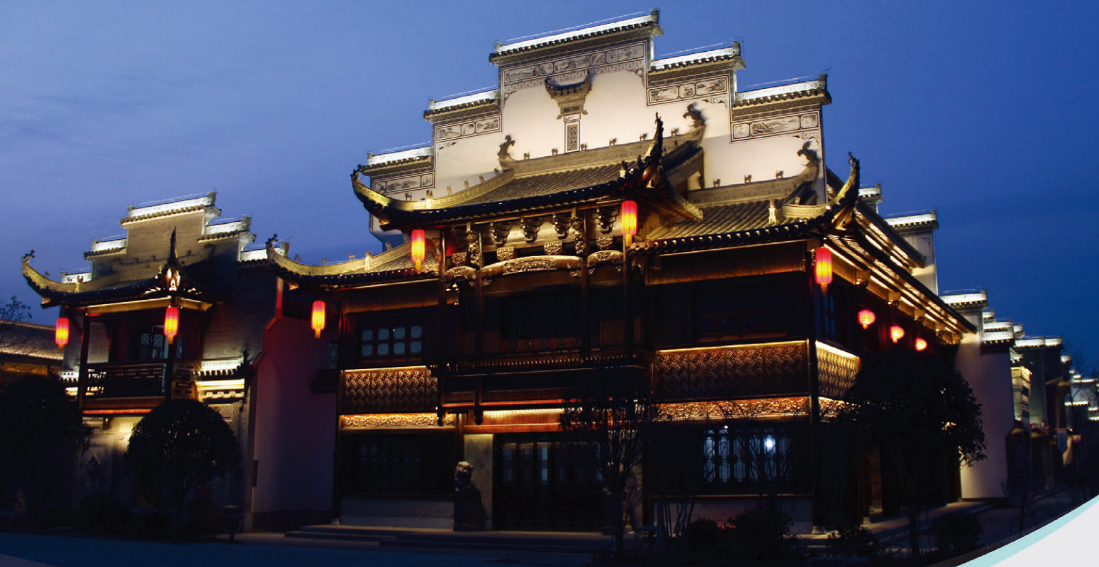
实景案例：安徽芜湖鸠兹古镇夜景照明
